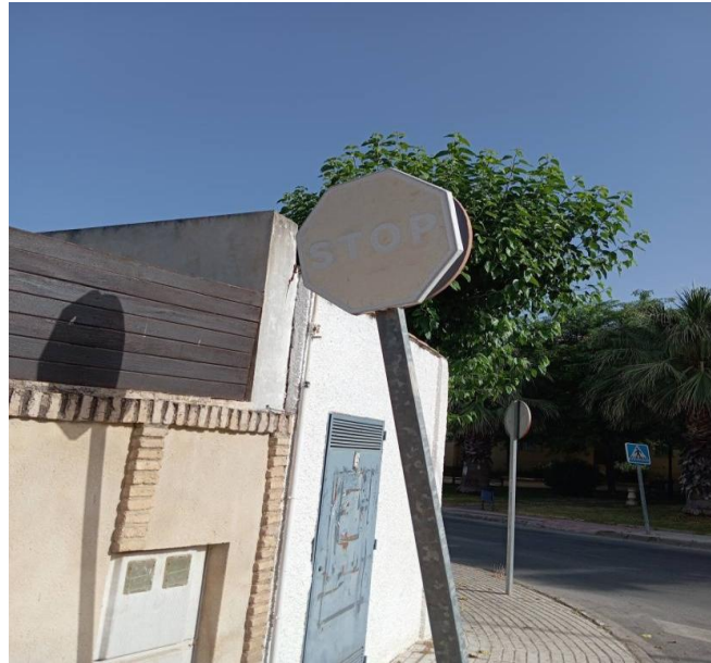
Fotografía 1. Señal deteriorada con pérdida de reflectancia.
