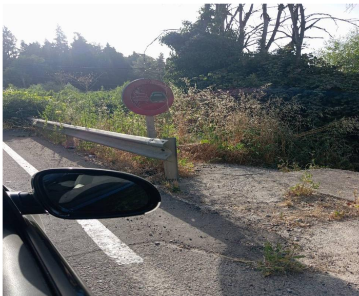
Fotografía 3. Señal parcialmente oculta por vegetación.
