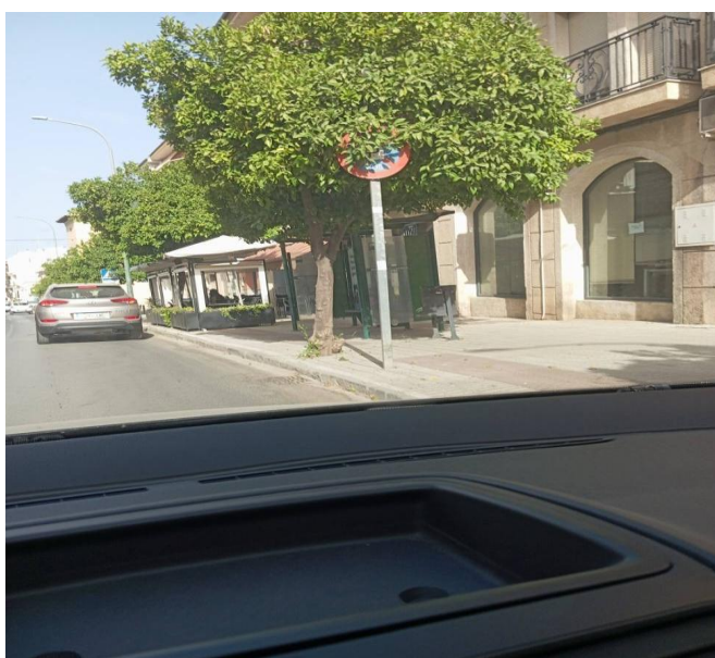
Fotografía 4. Señal con pérdida de visibilidad.
